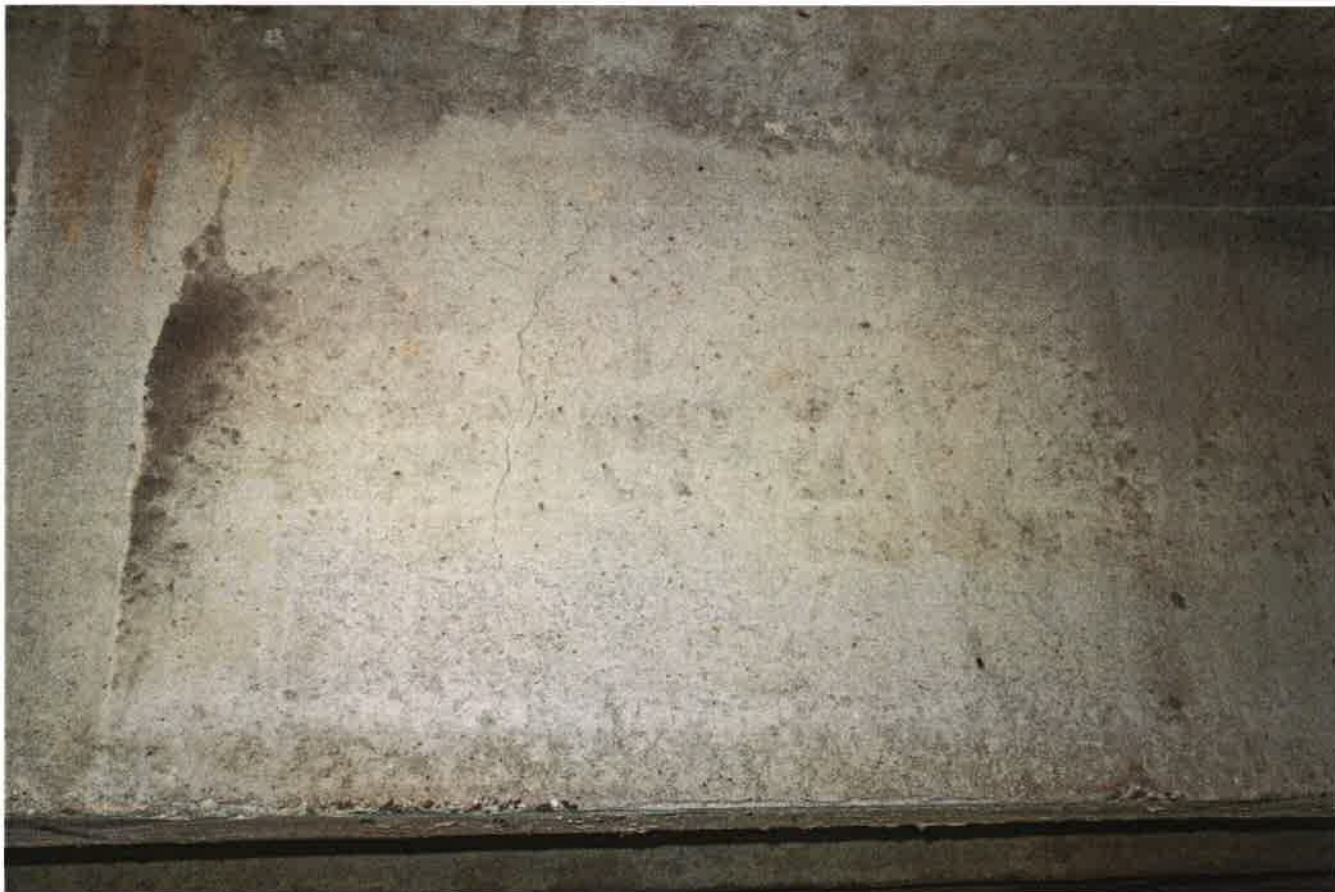
Foto nr.25. Grinzi. Apariția fisurilor transversale în grinzi.
