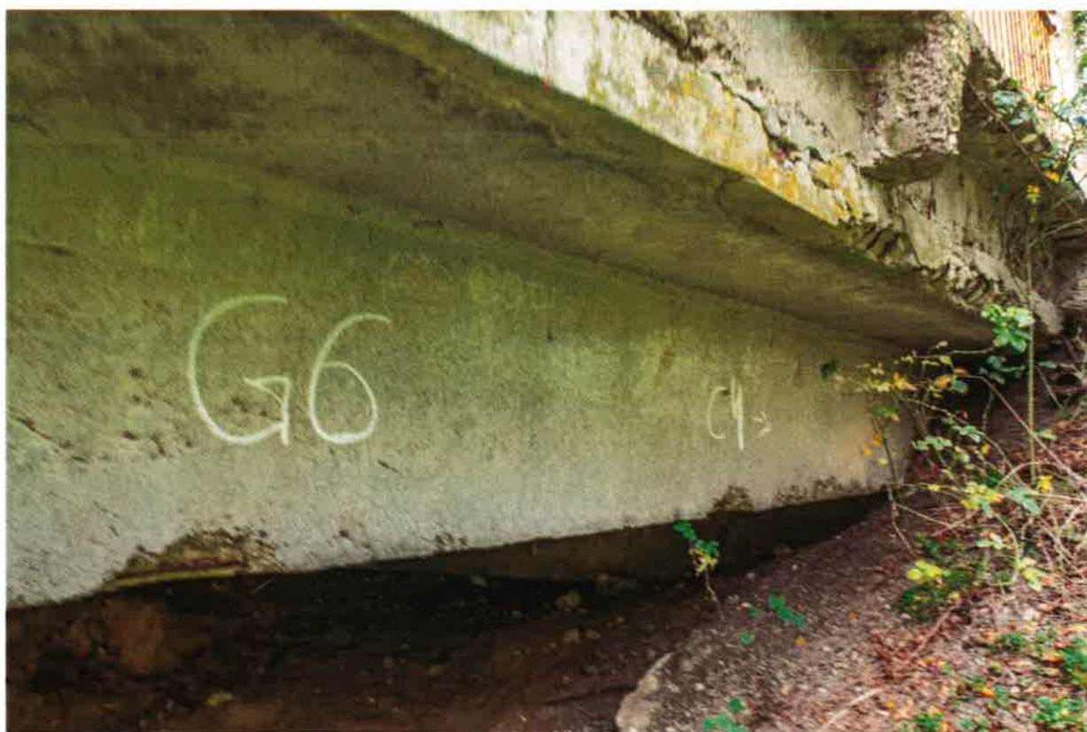
Foto nr.26. Grinzi Distrugerea stratului de protecție din beton cu dezgolirea și coroziunea armăturii. Ruperea unor sectoare de placă a grinzilor suprastructurii.
